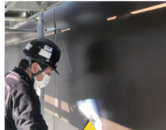
コーティング作業完了後
