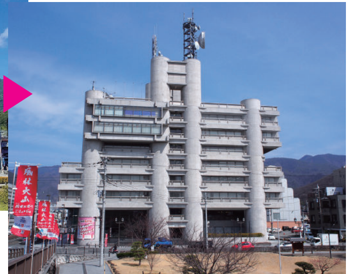
2025年3月 施工後 2年7ヶ月経過
