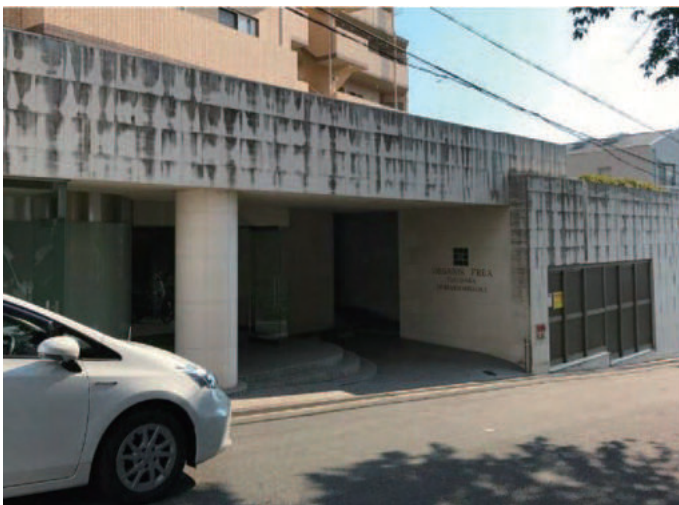
2017年 10月17日着工 施工前撮影
