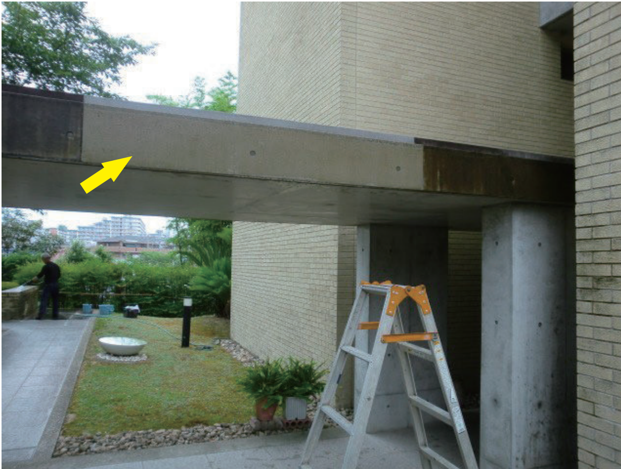
コンクリートの経年汚れを洗浄 (中央部をテスト施工)
