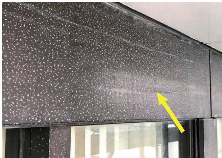
アルミ鋼板に白サビが発生して傷んでいる
