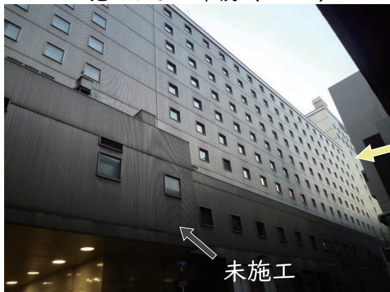
施工から1年後 (2013)
